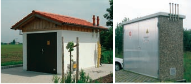
Gas-Druckregel- und Messanlagen
